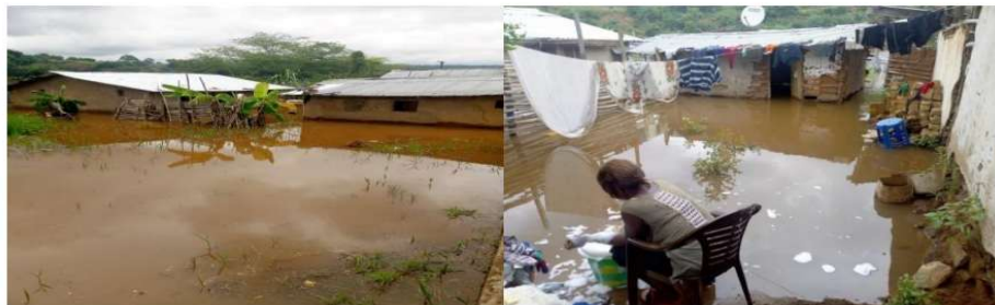
Planche 2 : Inondation des constructions érigées dans le lit majeur de la rivière Kwilu
