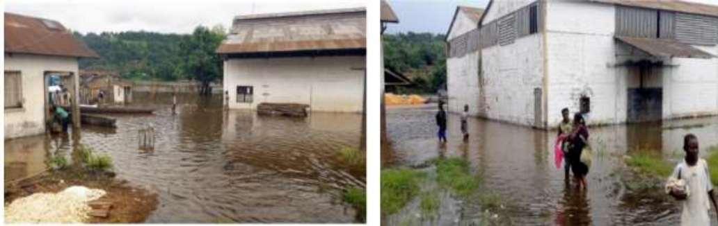
Planche 1 : Inondation du dépôt ONATRA par le débordement de la rivière Kwilu, Kakesa et al.2024
