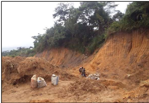
Photo 1 : Avenue Nzolana détruite par le ravin
