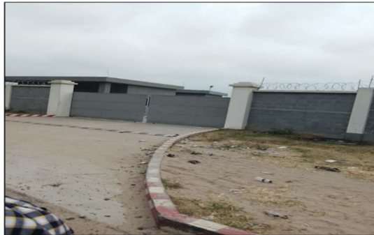
Photo n° 2: Station de pompage d'eau de la Regideso sur l'avenue Tourisme
