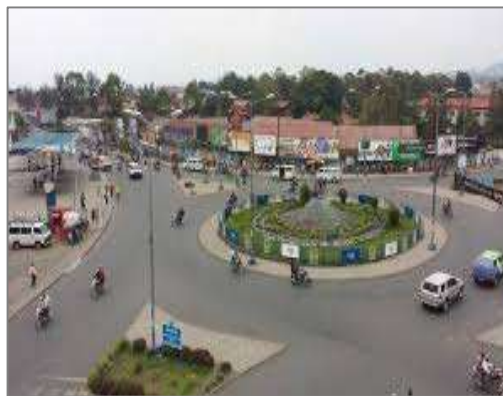
Photo 5. Réhabilitation de rond-point UPN
