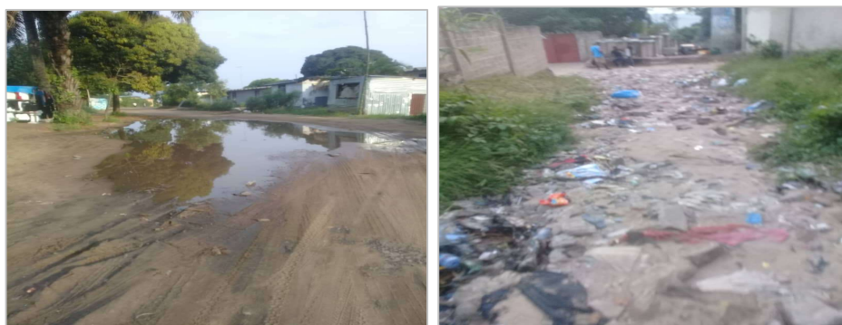
Photo 1 et 2. Etat des voiries dans les avenues Tuku et Camp Badiadingi
