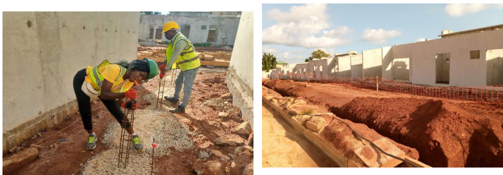
Planche 3 : Balisage et signalisation des zones de travaux et protection des fers en attente
