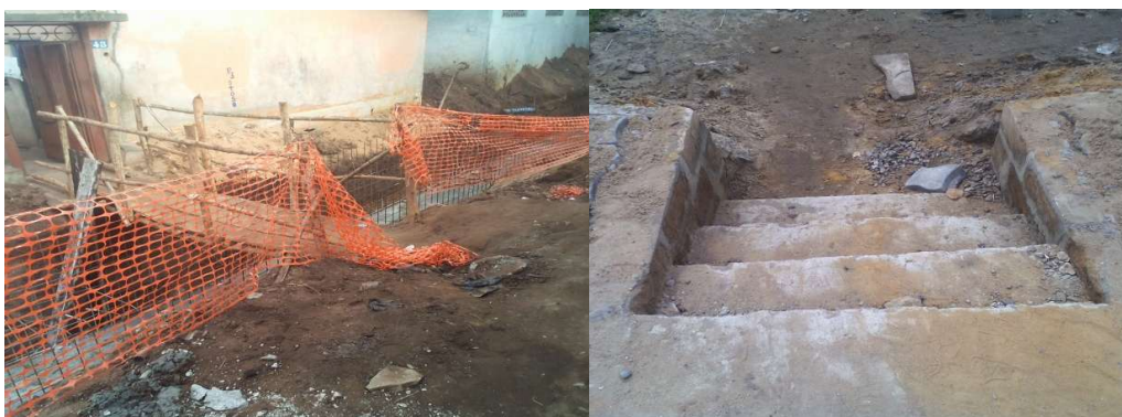
Planche 3 : Mise en place de dispositifs de facilitation d'accès aux habitations
