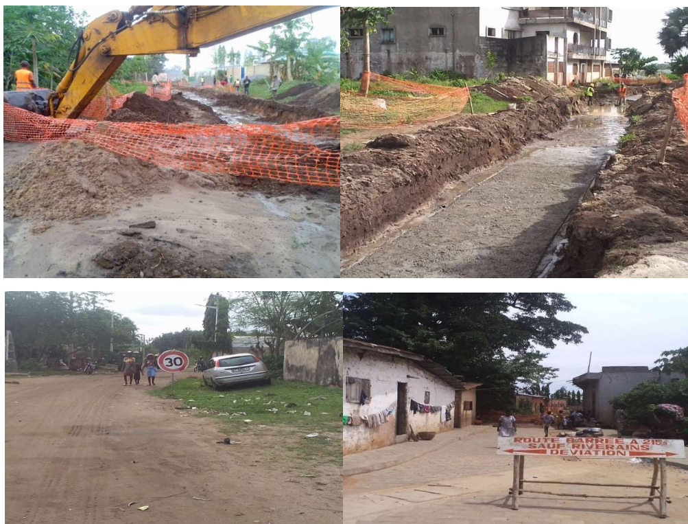
Planche 2 : Prise en compte des exigences de signalisation et balisage par l'entreprise
