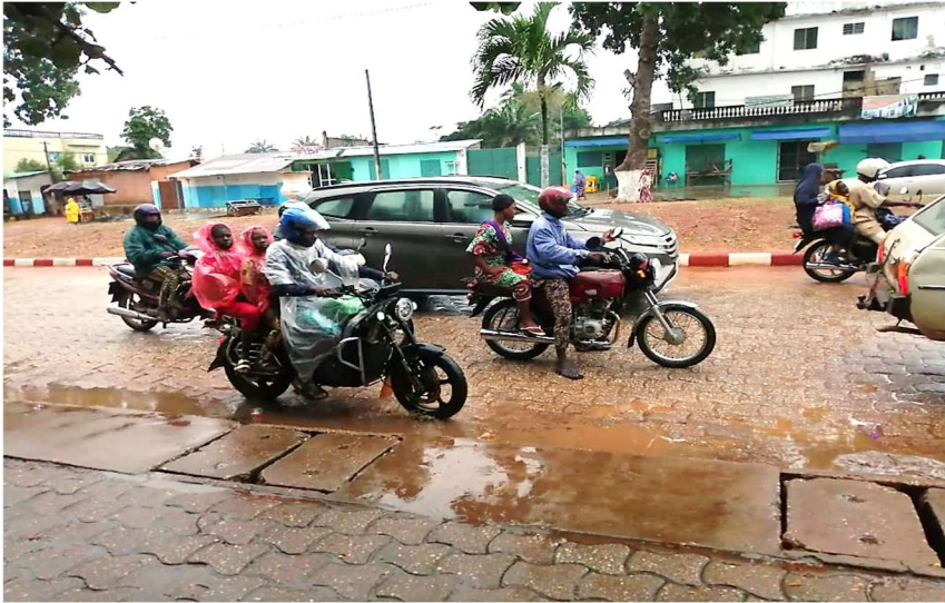
Photo 1 : Route avec caniveaux (boulevard du cinquantenaire à Porto-Novo)
