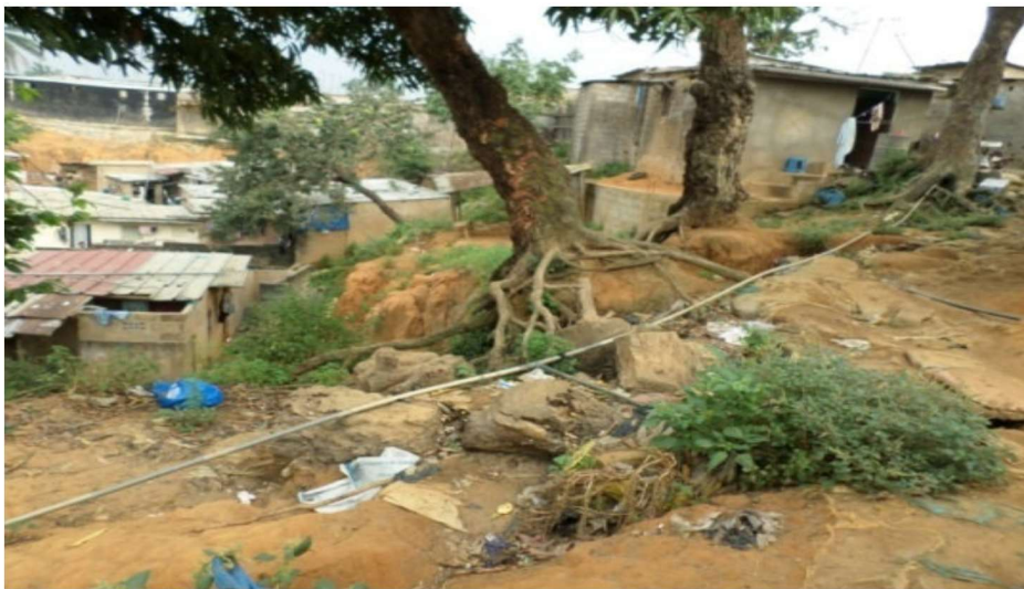
Photo 2 : un secteur du quartier Dioulabougou entièrement dégradé par l'érosion
