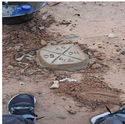
Fig. n° 1 : illustration des bornes implantées et construites
