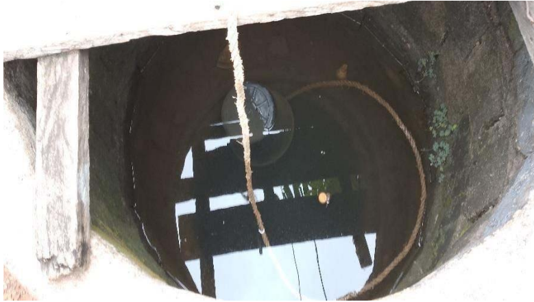
Figure 8 : Puit sommairement aménagé dans la zone (Nna, 2024)
