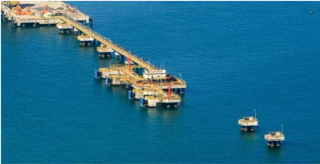
Fig. 2: Plateforme pétrolière (Source :_GRT)
