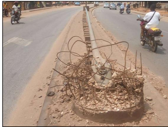
**Photo 1 :** Poteau d'éclairage de route endommagé par un accident de route à Abomey-Calavi
