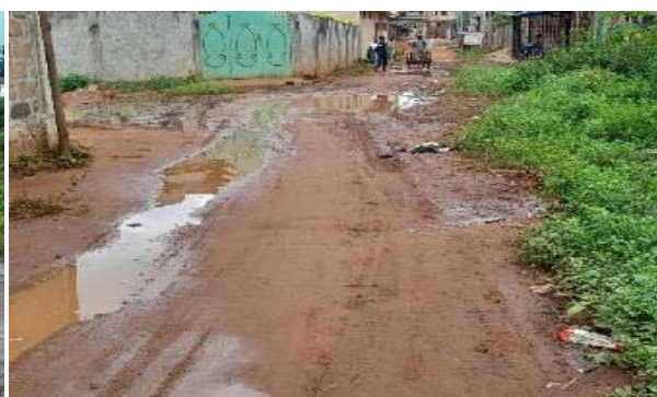
Photo 1 : Route dégradée à Hounsa-Assiobossa
