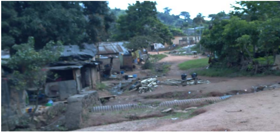
Photo 1 : Rue dégradée du fait de l'érosion au quartier commerce
