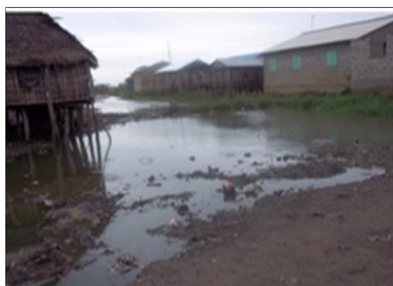
Photo 3 : Inondation des agglomérations à Aguégoués
