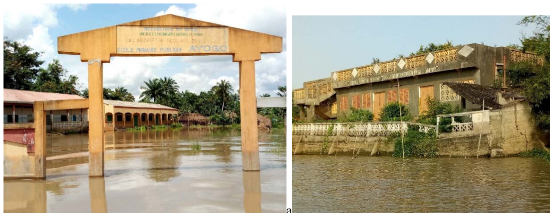
Photo 2 : Inondation de l’école à Ayogo et effondrement d’habitation à Agugégué
