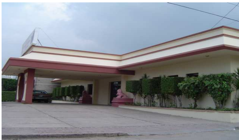
Figura4.- Fachada del Edificio 1
