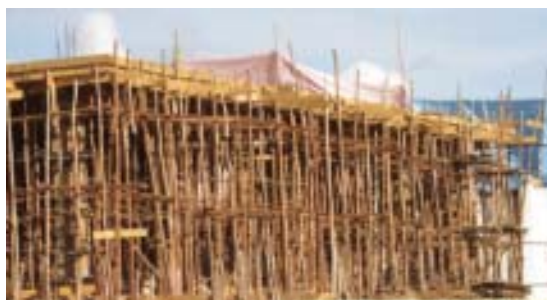
Cliché 7 : Echafaudage en bois
