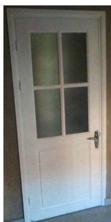
Cliché 6 : Porte semi-vitrée
