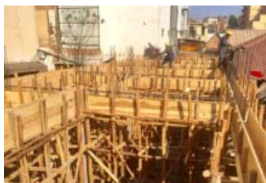
Cliché 4 : Coffrage en bois pour superstructure
