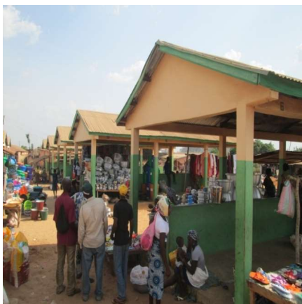
Photo 1 : Lot de hangars à matériaux définitifs dans le marché de Tchetti
