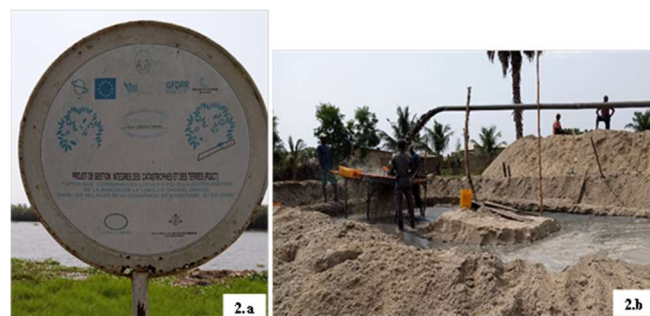
Planche 2 : Enseigne du Projet de Gestion Intégrée des Catastrophes et des Terres (PGICT) à Klouvidonou, Agouégan, Zébé et coupes des mangroves dans les berges de la lagune Gbaga à St Louis (Séko) (2.a) et Curage de la lagune Gbaga à Agoué-Centre (2.b)
