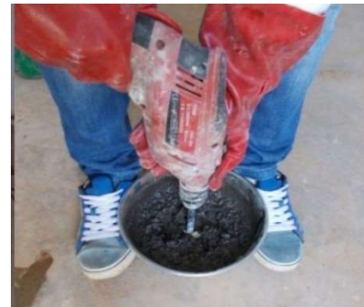
Photo 25 : Malaxage du mortier frais géopolymère
