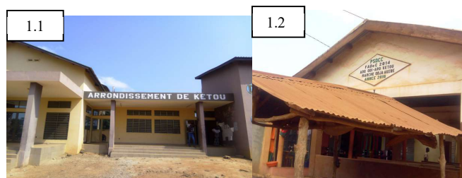
Planche 1: Bureau de l'arrondissement de Kétou et des hangars réalisés par la mairie avec le concours de l'Etat
