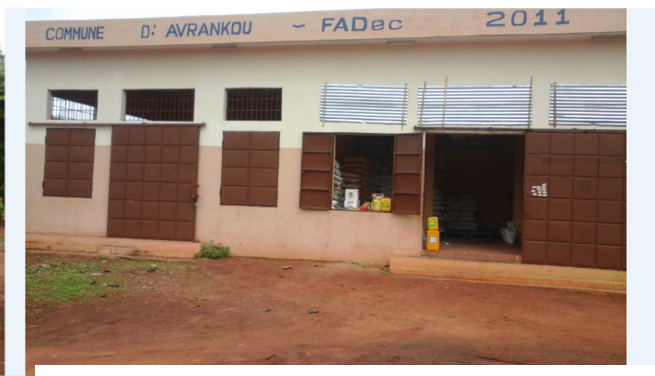
Photo 2 : Magasin de stockage construit à Avrankou
