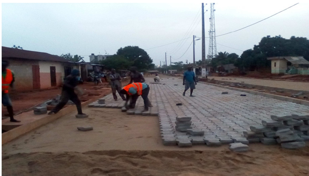
Photo 6 : Pavage d'une voie dans l'arrondissement d'Avrankou
