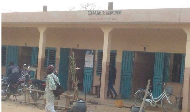
Photo 1 : Boutiques construites dans le marché central de Boukombé
